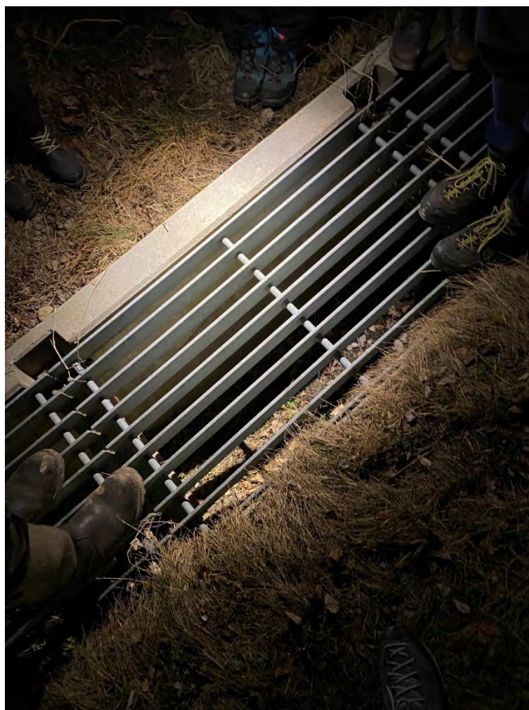
Slika 9: Rešetka za dvoživke (foto A. Lešnik).
