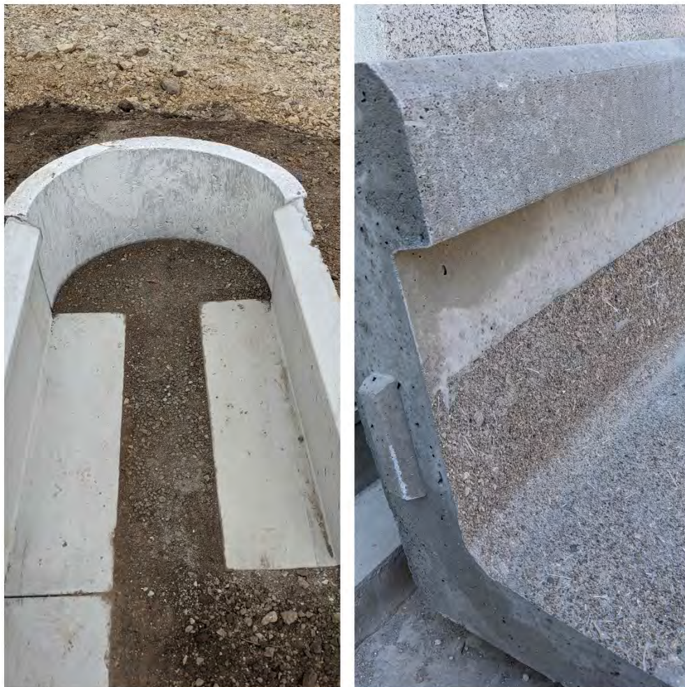
Slika 13: Zaključni U-element ograje-in pralni beton na pohodnih površinah elementa ograje (foto Katja Poboljšaj).
