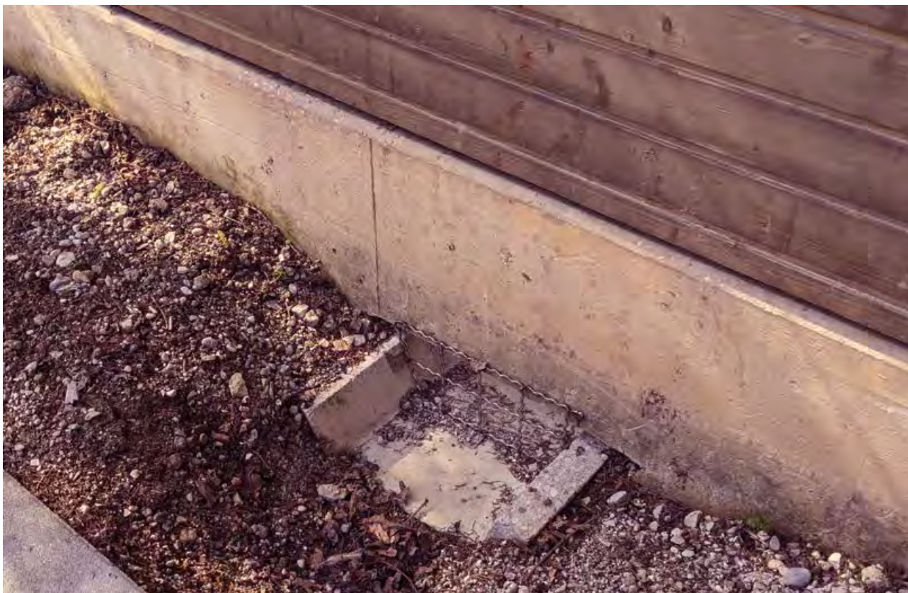
Slika 6: Obstoječa zaščita z mrežo na prehodih za dvoživke v ograji ZOO (foto: K. Poboljšaj).
